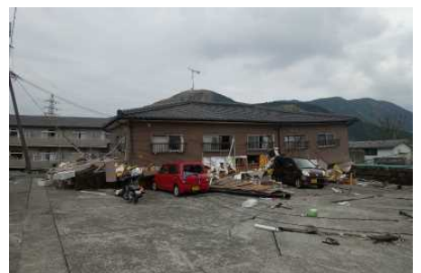
平成28年4月14日に発生した熊本地震により倒壊した木造アパート
