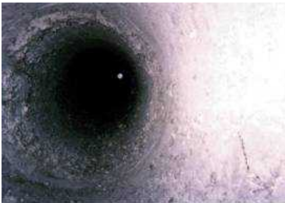
煙突の断熱材
