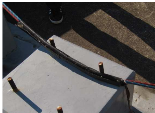
構造物の養生（巻き付け型養生材使用）
