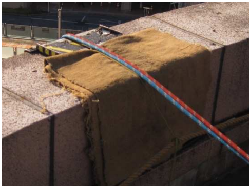
パラペット（建築物の端部）の養生
