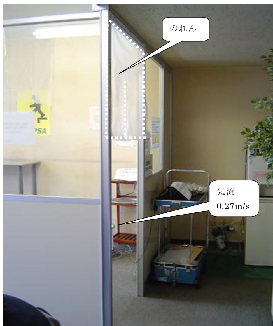
出入口にのれんを設置して、開口部分の気流を 0.20\text{m/s} から 0.27\text{m/s} に強化した事例（排気風量 1,160\text{m}^3/\text{h} ）
