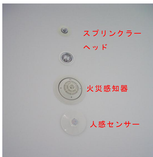
喫煙室にスプリンクラーヘッド及び感知器を増設した事例
