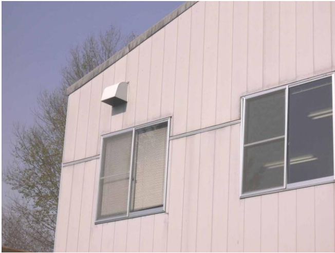
有圧換気扇、羽根径30cm
