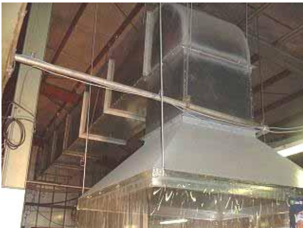
キャノピー型フードおよび排気ダクト
