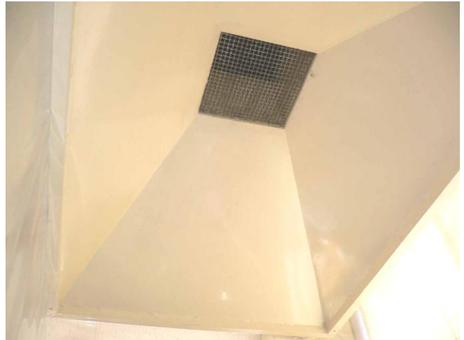
フード内天井部分の排気口 (0.35m×0.35m)
