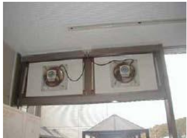
換気扇屋内側
