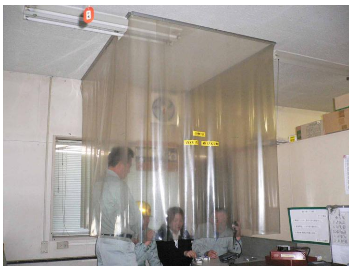
蛍光灯を横切る部分に隙間があるが煙の漏れはない。
