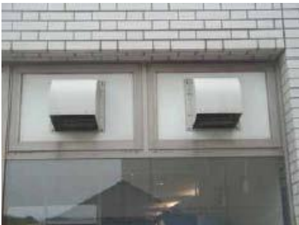
換気扇屋外側
