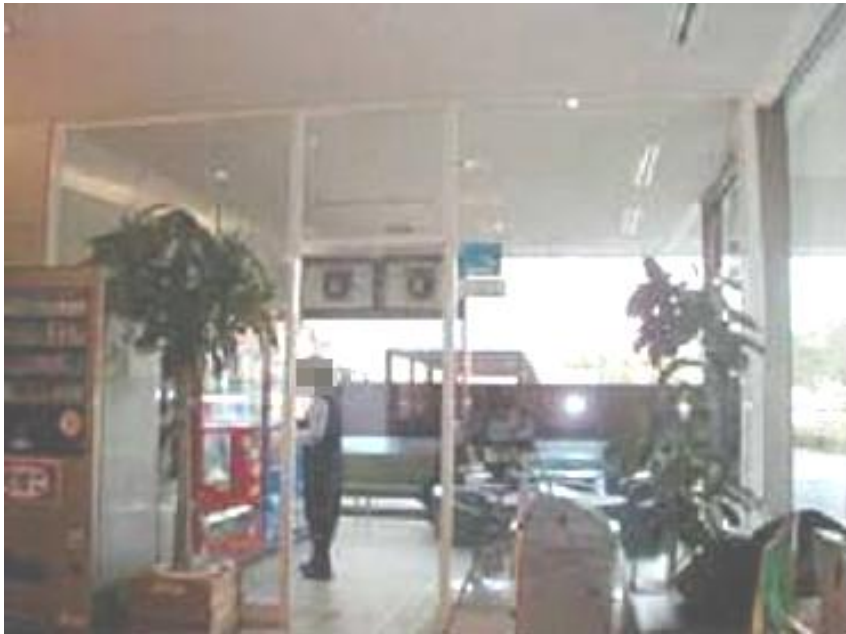
出入り口にドアはないが、煙の漏れはない。
