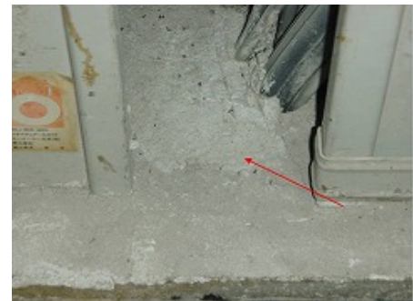
写真Ⅱ-12 電気配線部分隙間閉鎖
