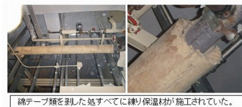
写真Ⅱ-14 直管部分にも使われる配管保温材
