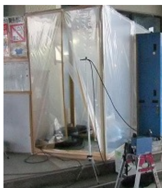
図-24 セキュリティーゾーンの入口前の測定例
