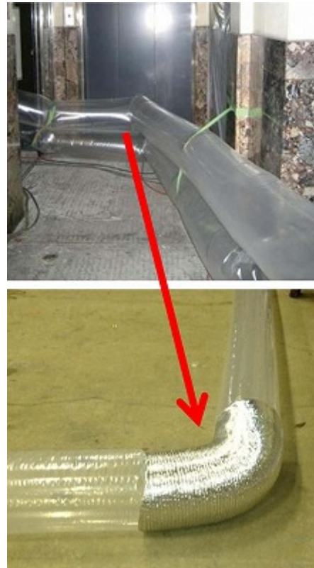
図-9 ビニールダクトの曲がり部分に環状の支え（アルミ製ダクト）をビニールダクトに重ねて使用した例
