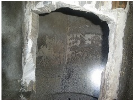
写真Ⅱ-9 ハイスタック煙突断熱材
