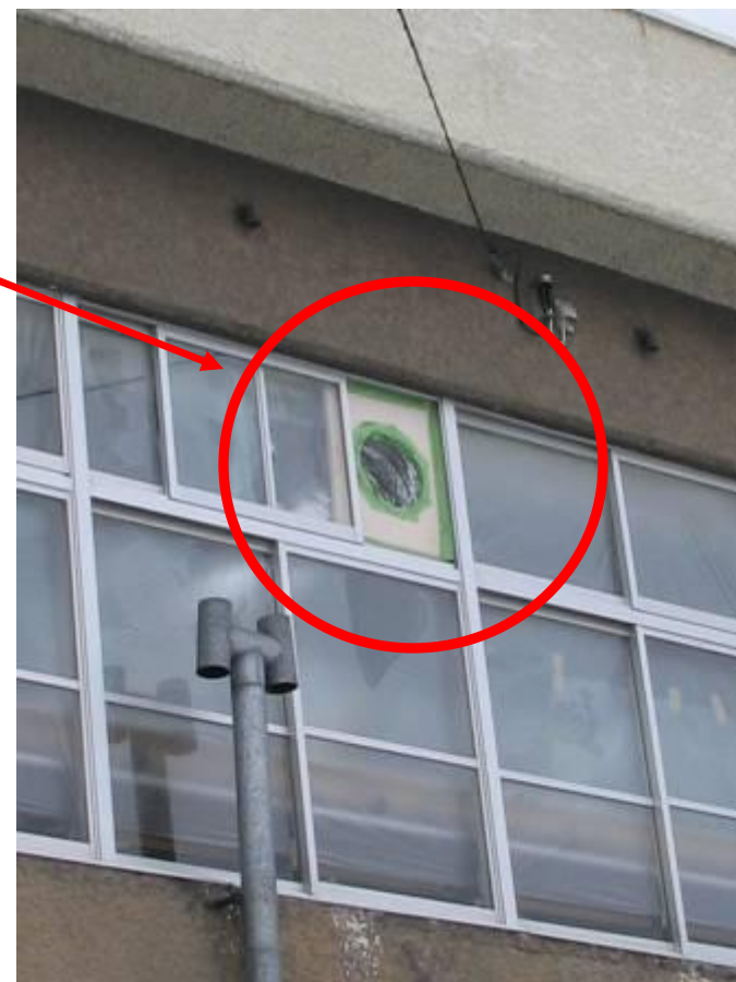
小学校教室外の排気口
