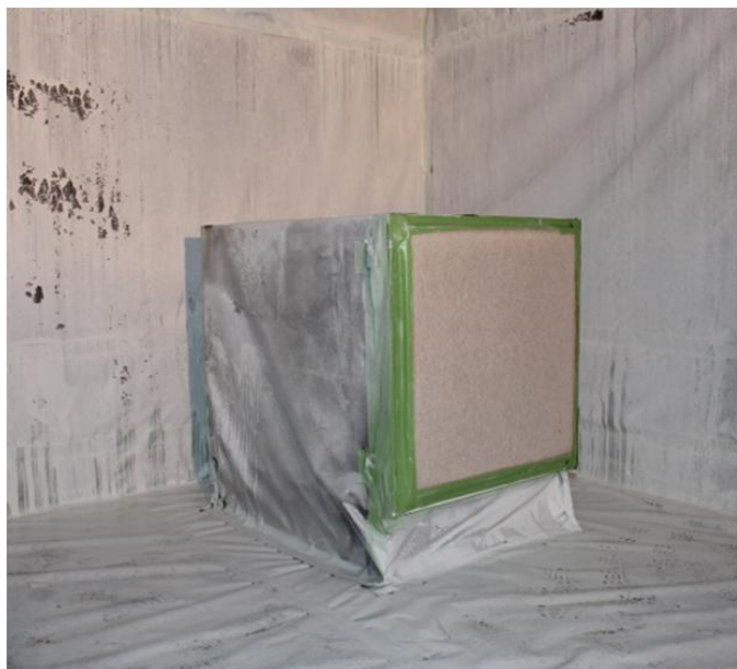
集じん・排気装置稼働
