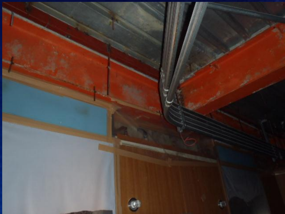
石綿除去処理区画相間養生
