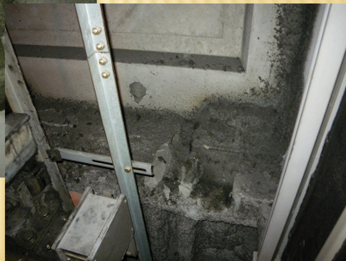
ELVシャフト内
