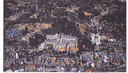
箱根病院(左端青い屋根が西病棟)
