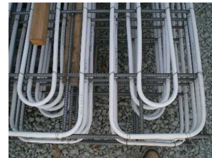
無散水融雪装置(曲げ加工部)
