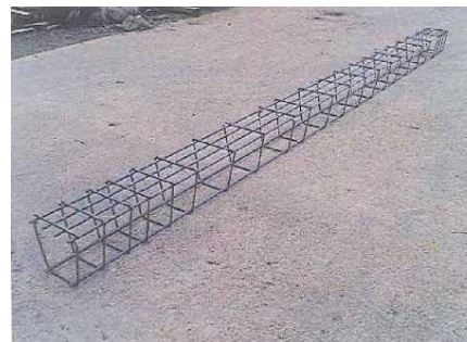
消雪用ブロック用の鉄筋かご
