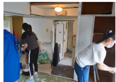
シェアハウスとして入居者自身でDIYしている様子
