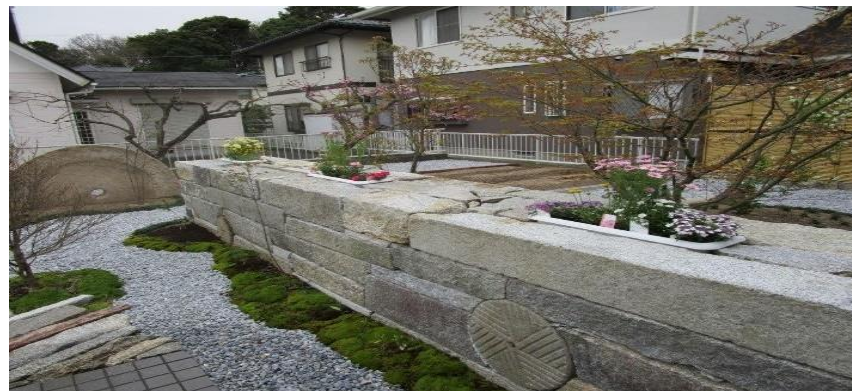
[古材の切石を使用し表情豊かな小端積みを作成]
