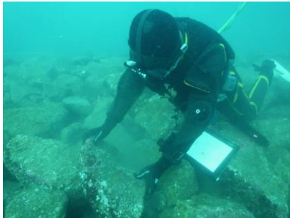
[基礎捨石均し技術の様子]
