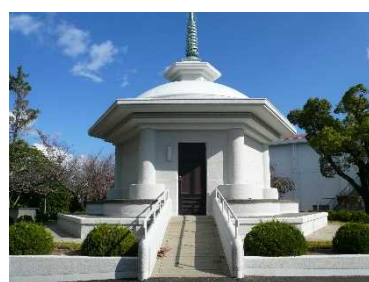
納骨堂納骨室入口
