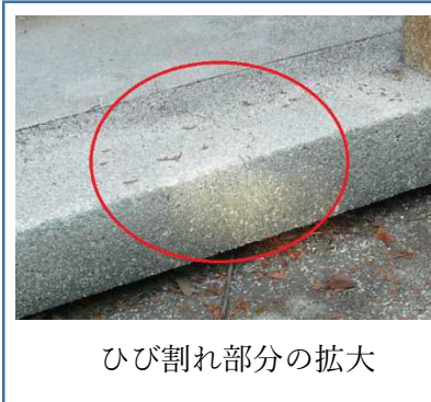
手すり部分の亀裂
