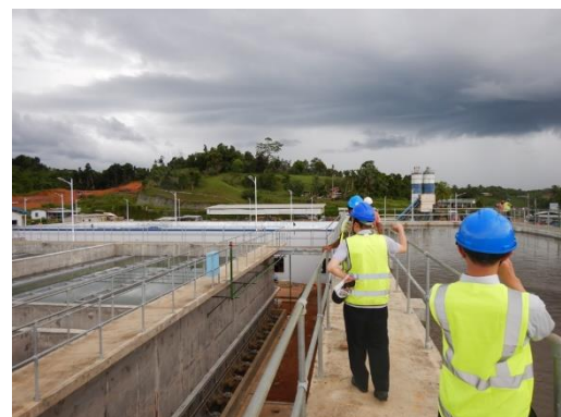
凝集沈殿池②
