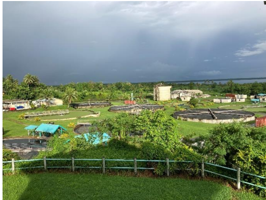
下水処理施設全景①
