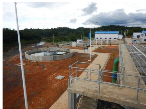
汚泥の沈殿池
