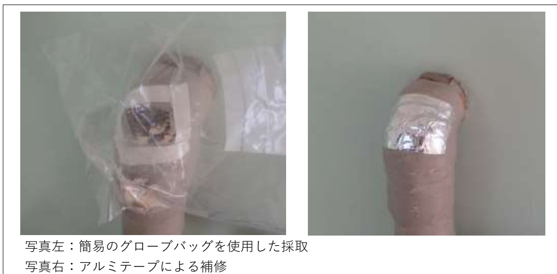
図 3.21 配管保温材の採取
