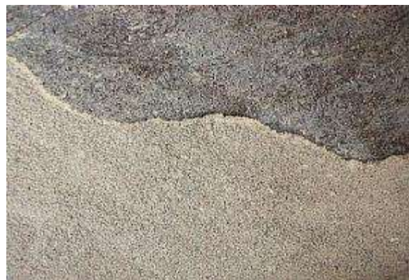
写真左：折板屋根の吹付け石綿の層状界面はく離 写真右：木毛セメント板（上）下地の浮いた吹付け石綿（下）の界面はく離
