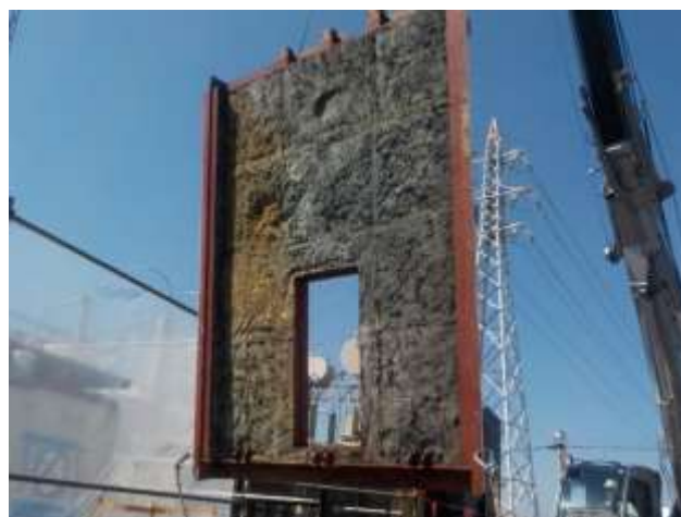
図 2.79 防音材（変電）
