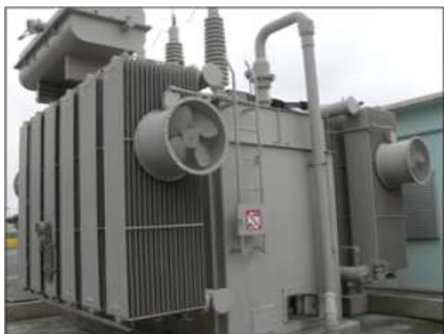
図 2.79 防音材（変電）
