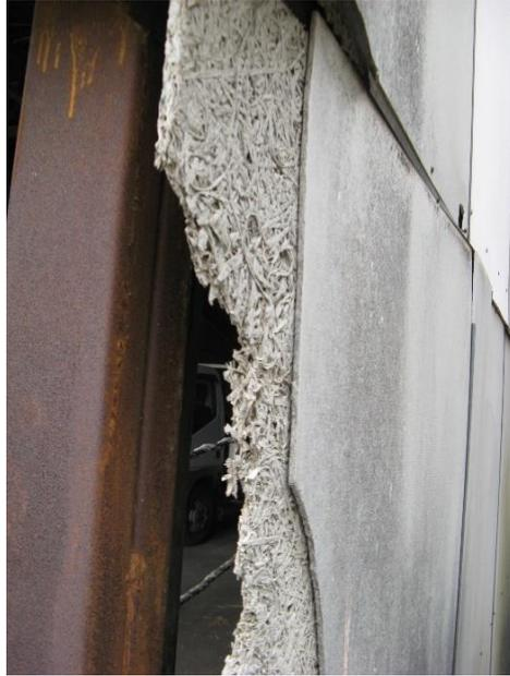
図 2.51 複合ボードの施工例
