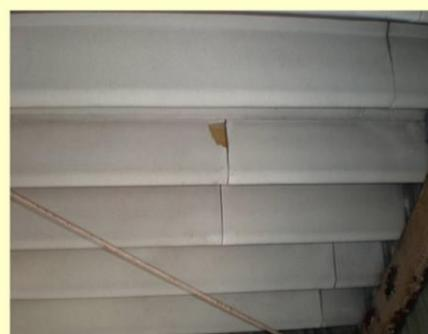
断熱・結露防止を兼ねて、折板屋根の内側に石綿含有炭酸カルシウム発泡断熱材が貼られている
