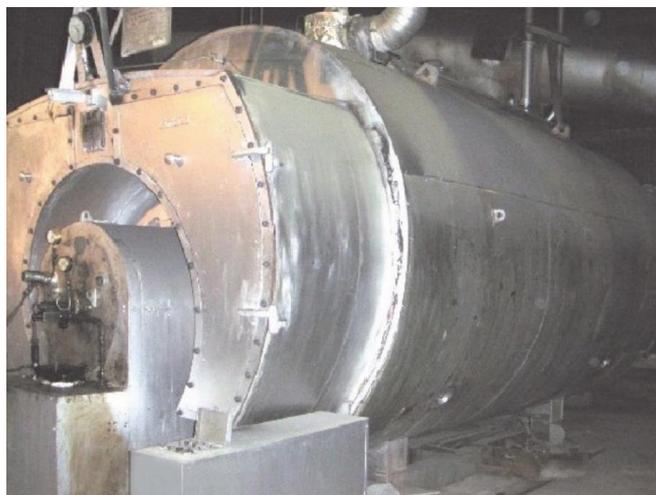
図 2.30 ボイラーに施工された保温材
