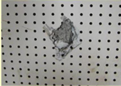
けい酸カルシウム板の裏側に吹付け石綿が施工されている
