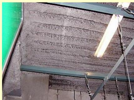
断熱のため、床スラブ(デッキプレート)裏面に石綿含有ロックウールが吹付けられている
