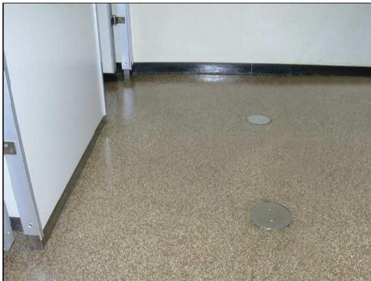
図 2.57 石綿含有ビニル床シートの施工例
