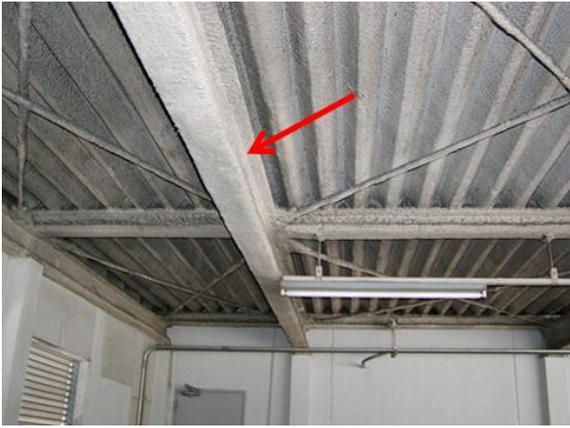
図 2.6 鉄骨はりの吹付け耐火被覆
