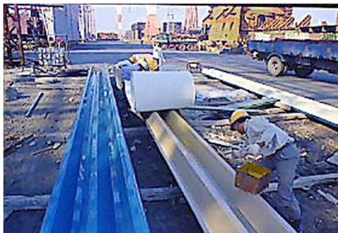
10 図 2.35 屋根用折板石綿断熱材施工例
