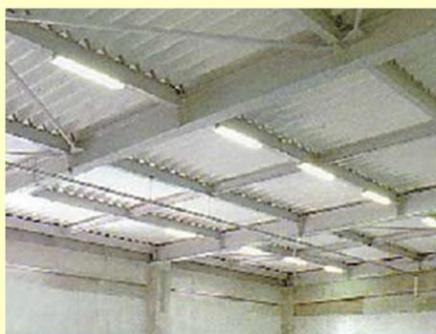
断熱・結露防止を兼ねて、折板屋根の内側に屋根用折板石綿断熱材が貼られている
