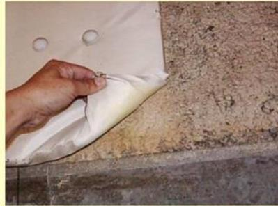
改修工事の際、吹付け石綿の上にグラスウール板ガラスクロス押さえを行っている
