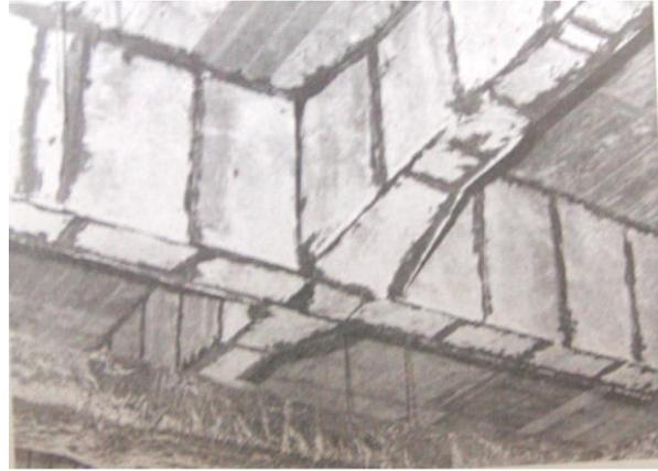
図 2.7 鉄骨はりの石綿耐火被覆板
