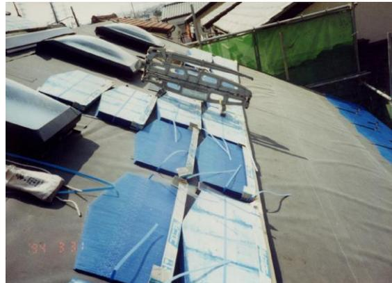
図 2.64 石綿含有ルーフィングの施工例
