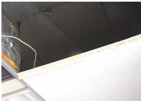
8F(RFスラブ下) 事務室(空室・改修予定部屋)、天井裏確認したが断熱材はない
