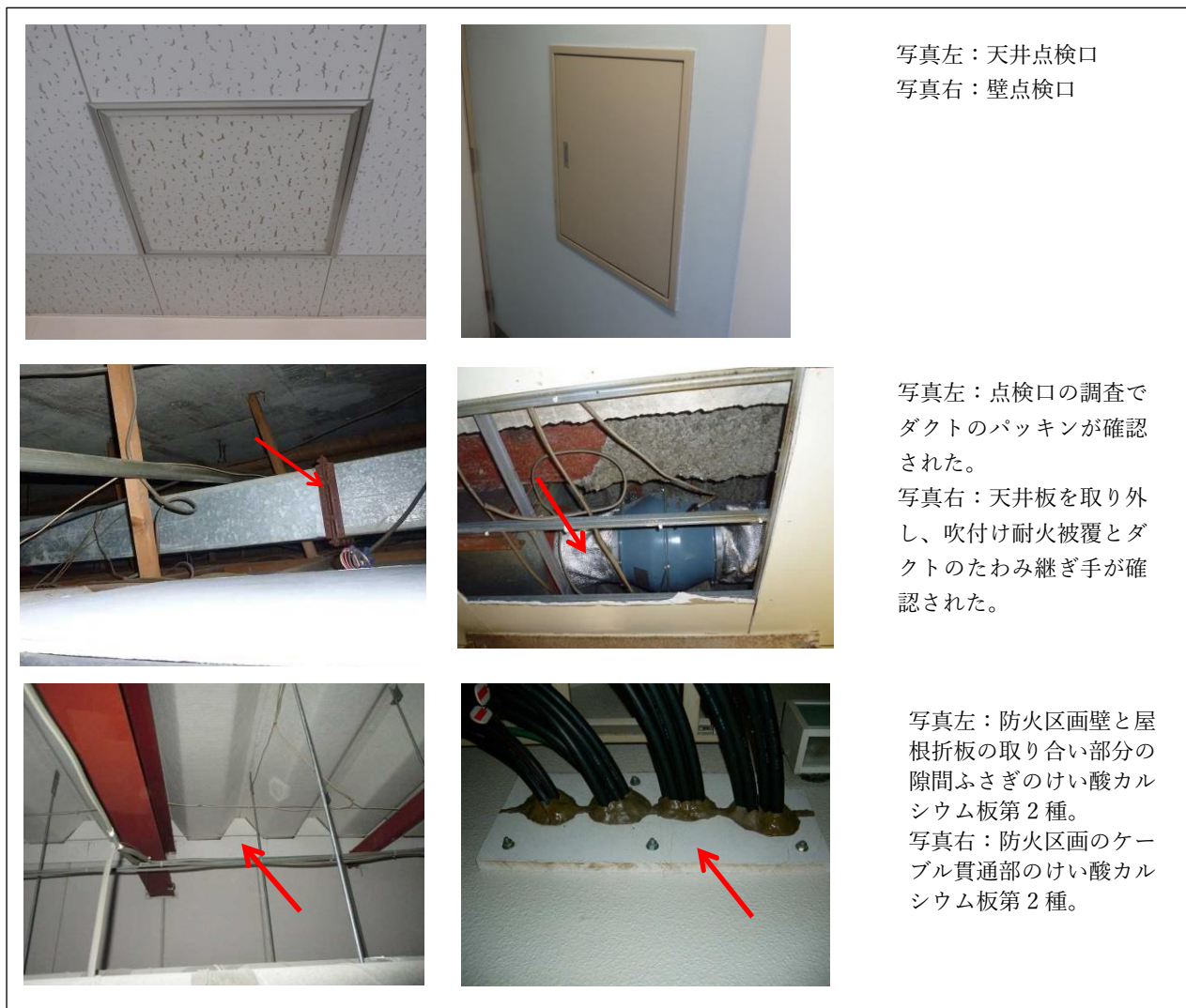
図 3.11 隠ぺい部の調査
