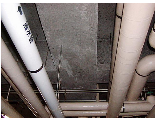
(やや劣化) 設備改修時の大きな擦過傷が複数箇所ある。
