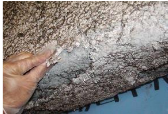
耐火被覆 吹付け石綿（クロシドライト）に改修で石綿不含有RW上吹き処理
