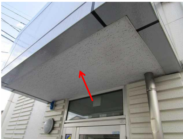
写真左: 軒天井のロックウール吸音天井板
