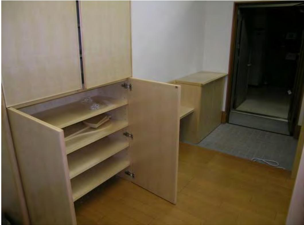
図II-6-43 玄関収納（車椅子収納に対応可能な可動棚）
