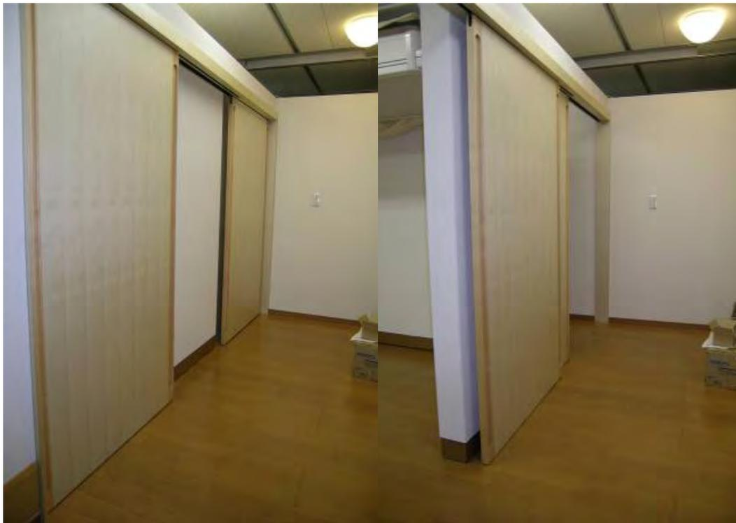
図II-6-39 アクティブキャスター設置対応引き戸と通常自動ドアタイプ引き戸の開閉時
