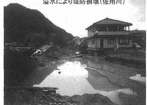
溢水により堤防損壊(佐用川)
