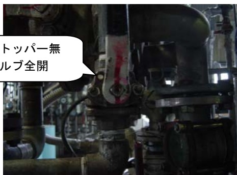
写真 7 DMF 流量調整バルブ 改善前／バルブ全開
