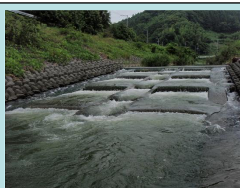
頭首工と魚道(全景)
