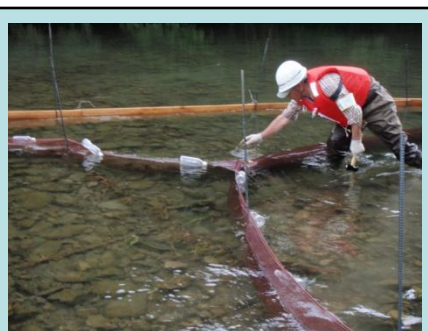
定置網設置状況
