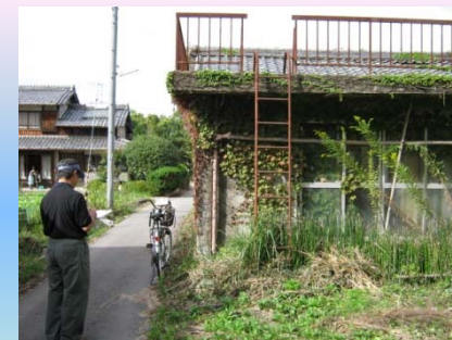
【京都府木津川市】 空き家・廃屋調査
