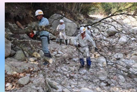
【三重県菰野町】 散策路の整備
