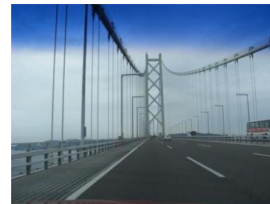
明石海峡大橋
