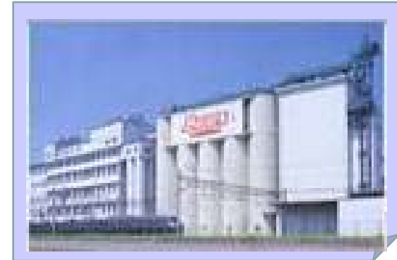
熊本製粉株式会社熊本工場
