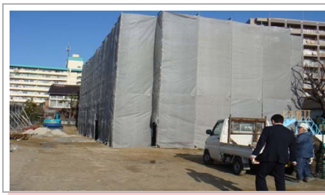
現在建設中の2階建て第1第2日明クラブ
